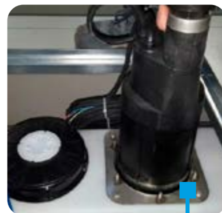
STAFFA RINFORZATA PER MONTAGGIO POMPA SOMMERSA
