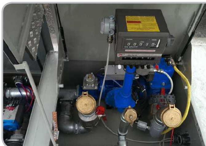
Scarico a caduta/pressione con sensore qualità prodotto AT04914
